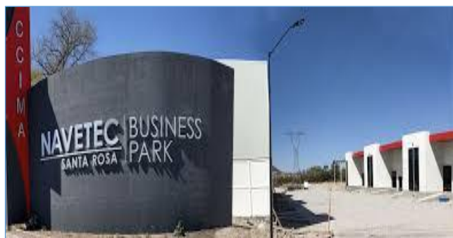
Foto: Entrada do Condomínio Industrial
