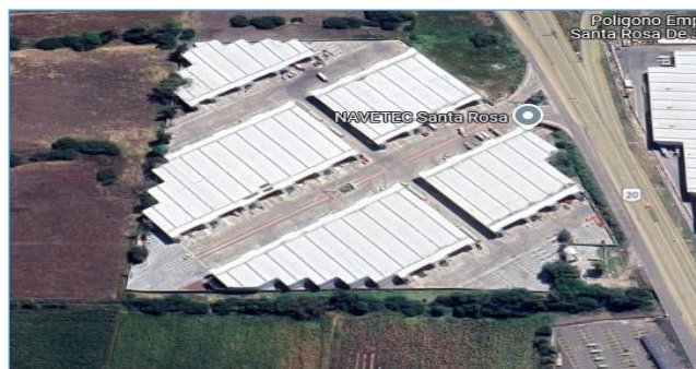
Foto: Vista Aérea do Condomínio Industrial
